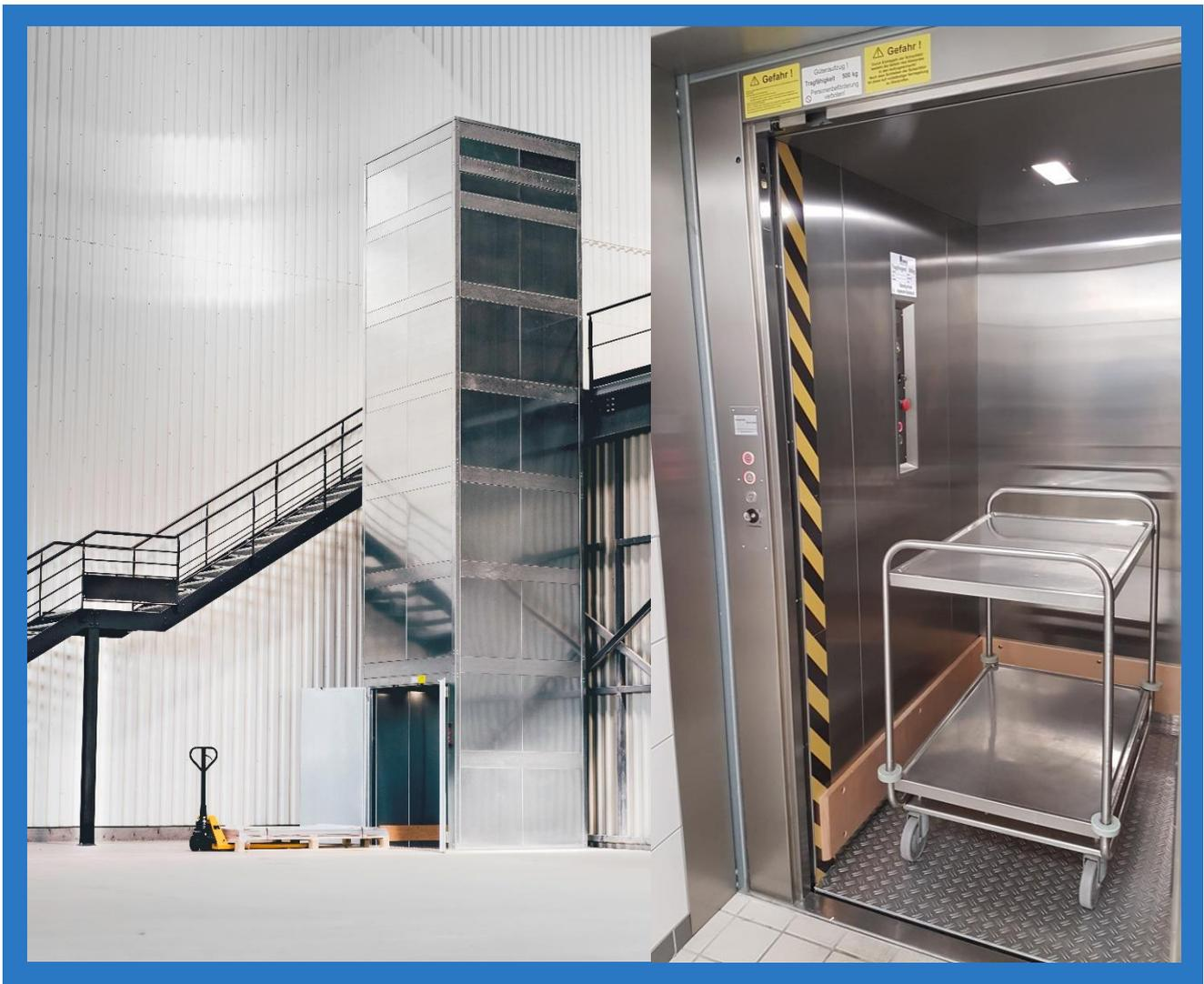
CARGO Line Max **FM** = Freistehende **M**ontage „CARGO Line Max **BS**“ = Montage im **B**eton-**S**chacht
