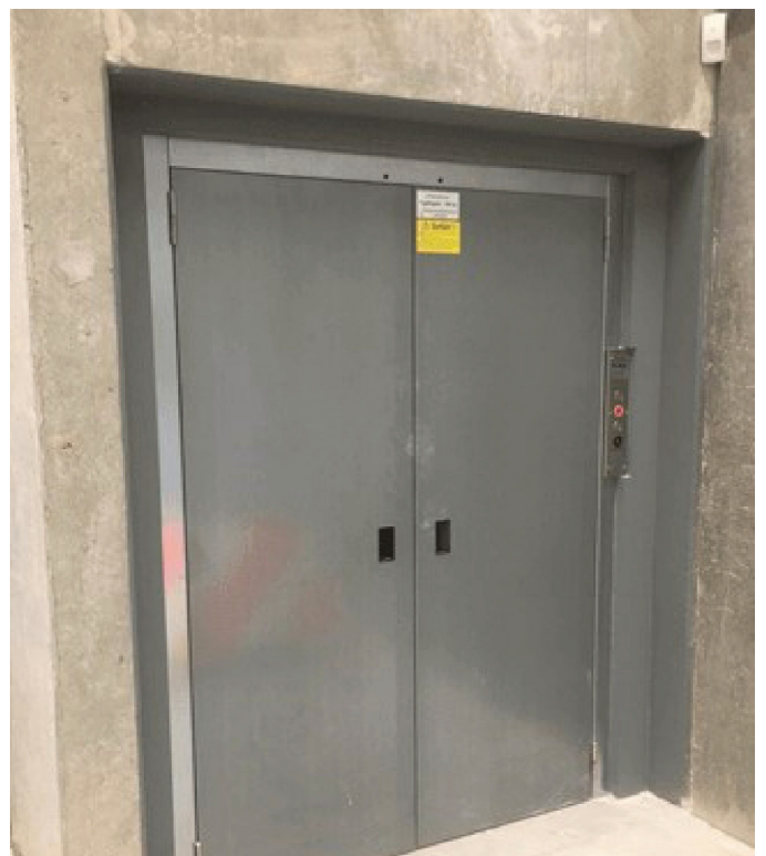
„CARGO Line Max BS“ = Montage im Beton-Schacht
