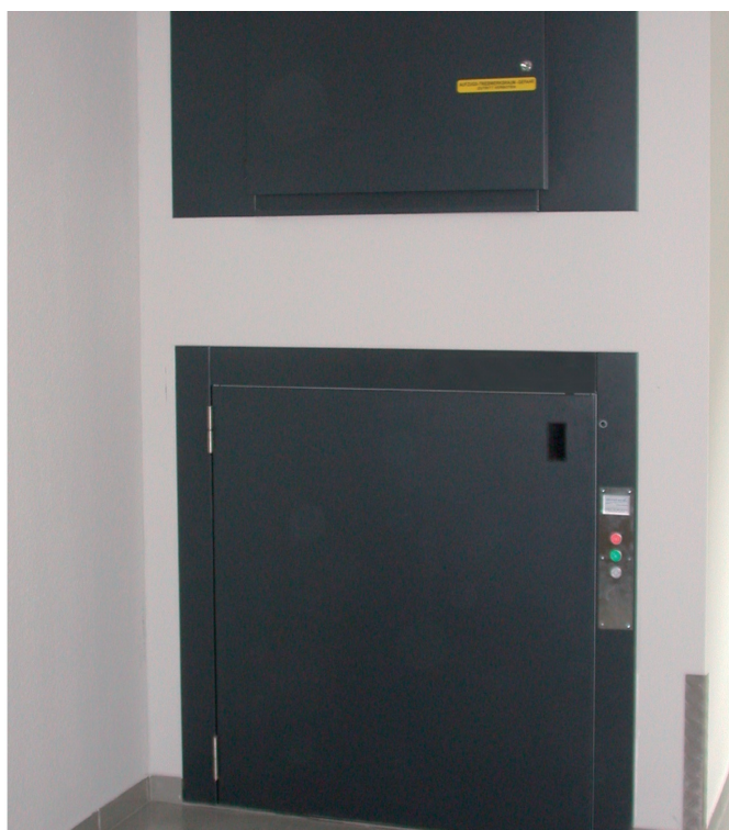
... obere Haltestelle mit Triebwerksraum
