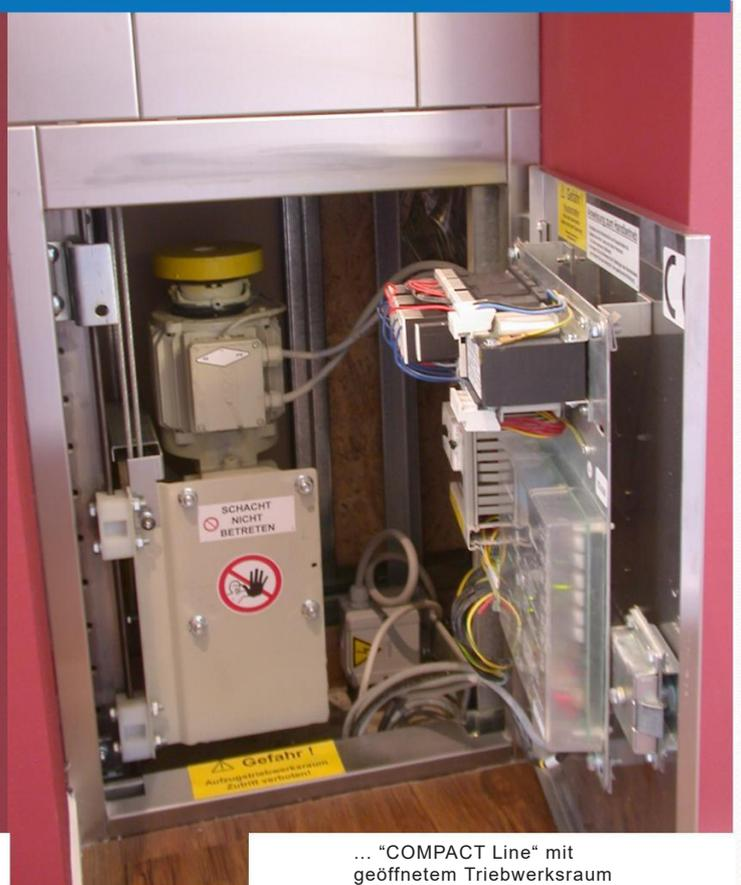
... "COMPACT Line" mit geöffnetem Triebwerksraum
