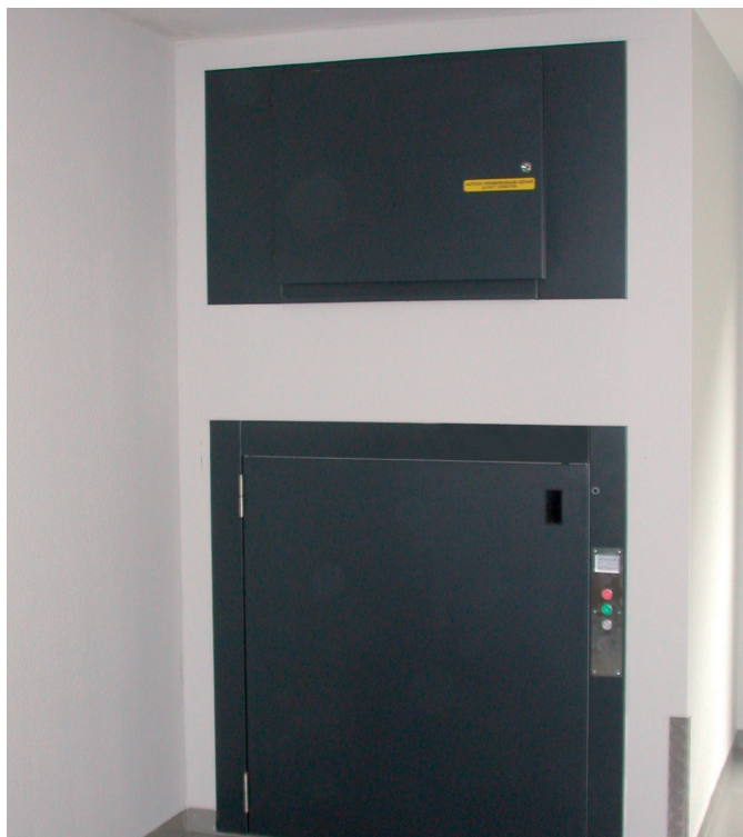
... „CARGO Line“ obere Haltestelle mit Triebswerkraum
